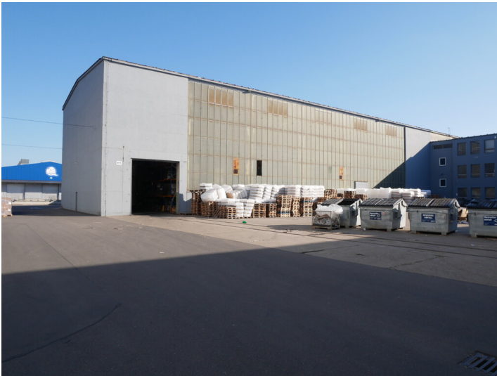
Zentralwerkstatt Kraftwerk Vetschau Fotograf/Urheber: Franz Dietzmann
