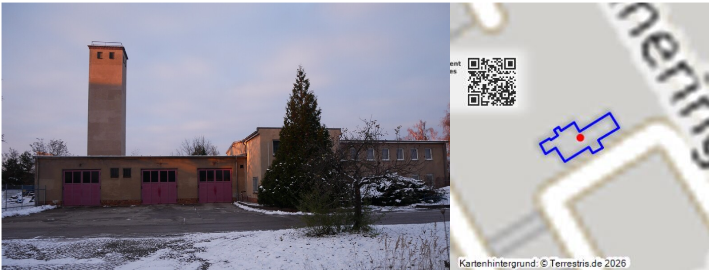
Feuerwehr Kraftwerk Vetschau Fotograf/Urheber: Kaja Boelcke
