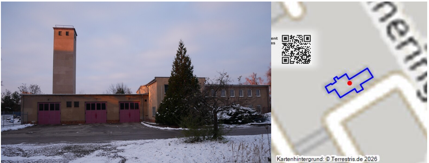
Feuerwehr Kraftwerk Vetschau Fotograf/Urheber: Kaja Boelcke
