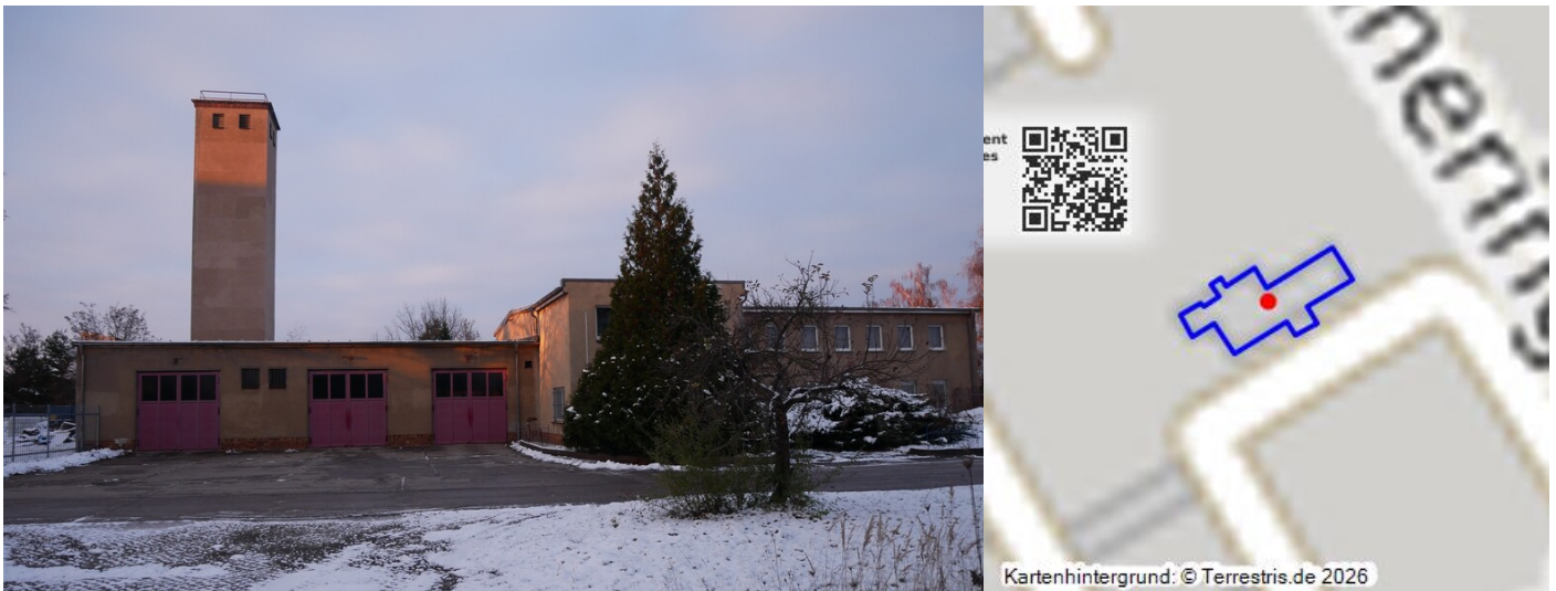
Feuerwehr Kraftwerk Vetschau Fotograf/Urheber: Kaja Boelcke
