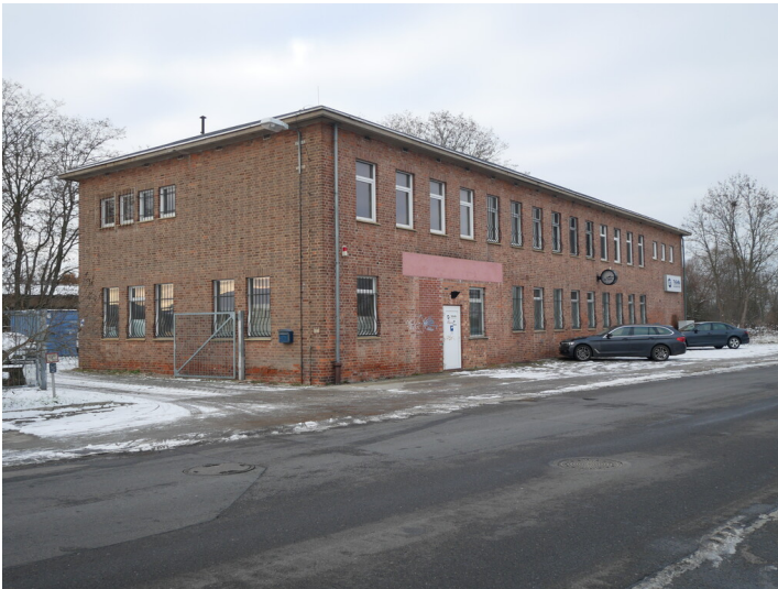
Pförtnerhaus Kraftwerk Lübbenau Fotograf/Urheber: Kaja Boelcke
