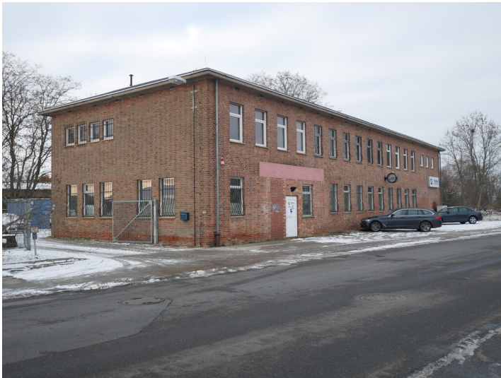
Pförtnerhaus Kraftwerk Lübbenau Fotograf/Urheber: Kaja Boelcke
