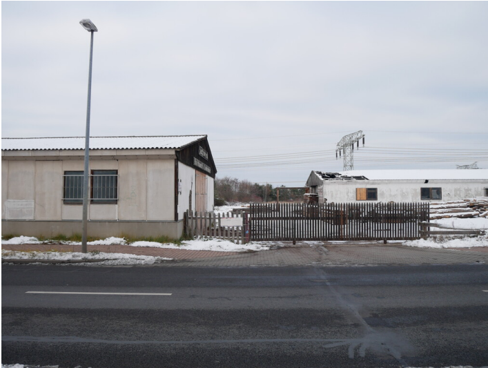
Baracken Kraftwerk Lübbenau Fotograf/Urheber: Kaja Boelcke
