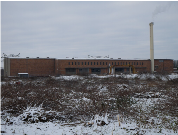
Umspannwerk Kraftwerk Lübbenau Fotograf/Urheber: Kaja Boelcke
