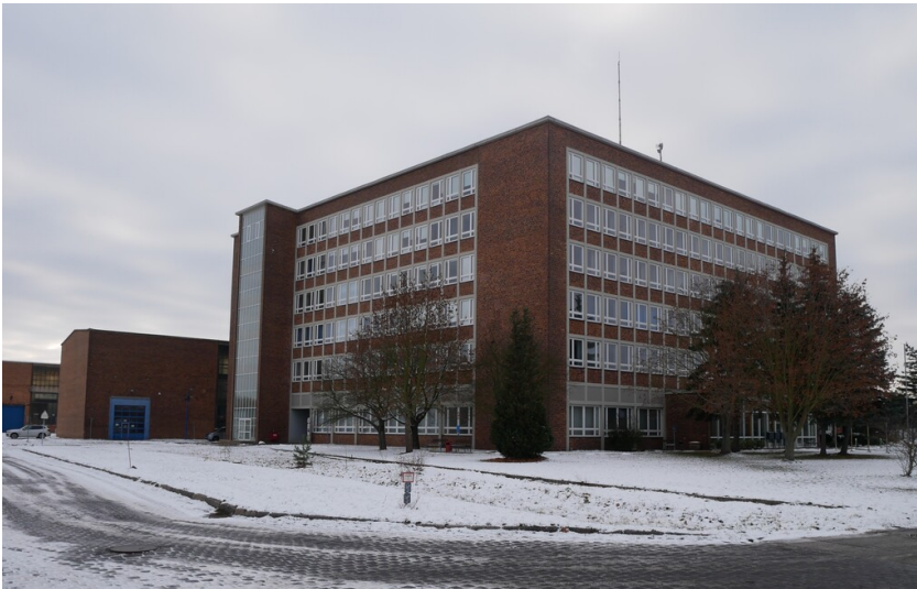
Verwaltungsgebäude Kraftwerk Lübbenau Fotograf/Urheber: Kaja Boelcke
