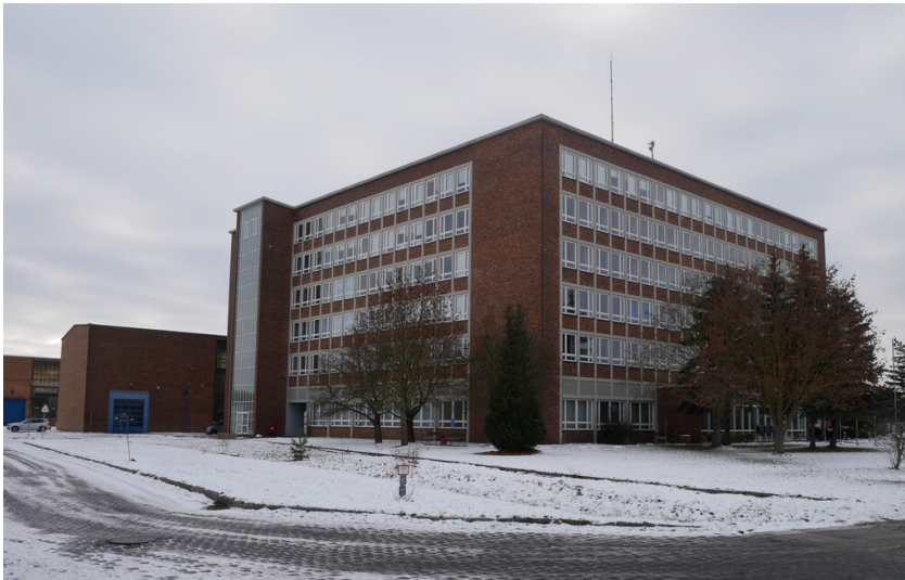
Verwaltungsgebäude Kraftwerk Lübbenau Fotograf/Urheber: Kaja Boelcke
