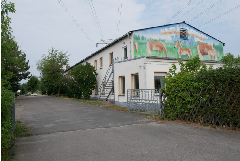
Zentraler Gleisstützpunkt Fotograf/Urheber: Kaja Boelcke
