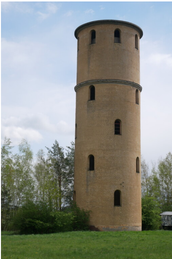
Wasserturm Greifenhain Fotograf/Urheber: Franz Dietzmann
