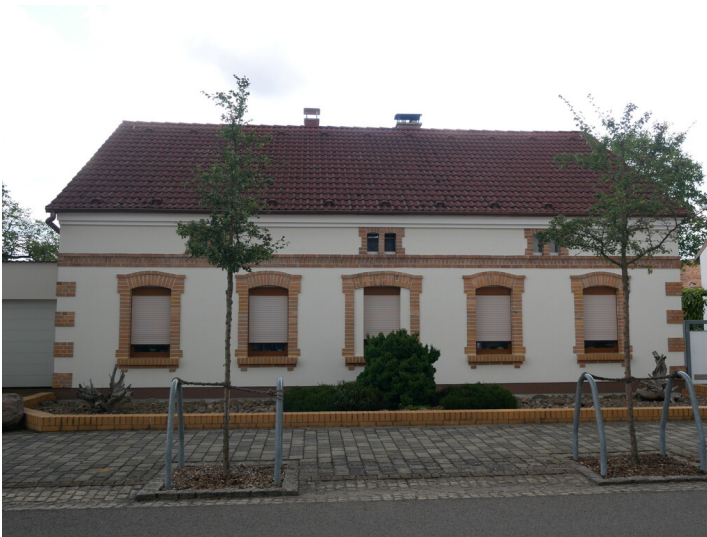
Siedlung der Glasarbeiter Fotograf/Urheber: Dr. Barbara Kündiger
