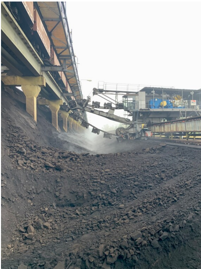
Grabenbunker Kraftwerk Jänschwalde (2022) Fotograf/Urheber: Kaja Boelcke
