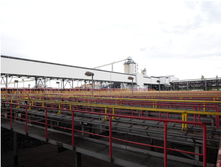
Rinnenanlage Fotograf/Urheber: Kaja Boelcke
