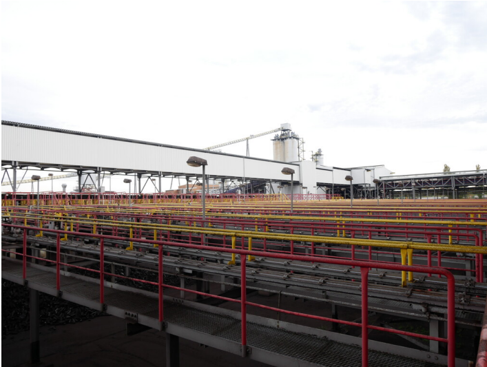
Rinnenanlage Fotograf/Urheber: Kaja Boelcke
