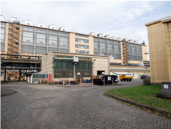
Kondensatstation Fotograf/Urheber: Kaja Boelcke
