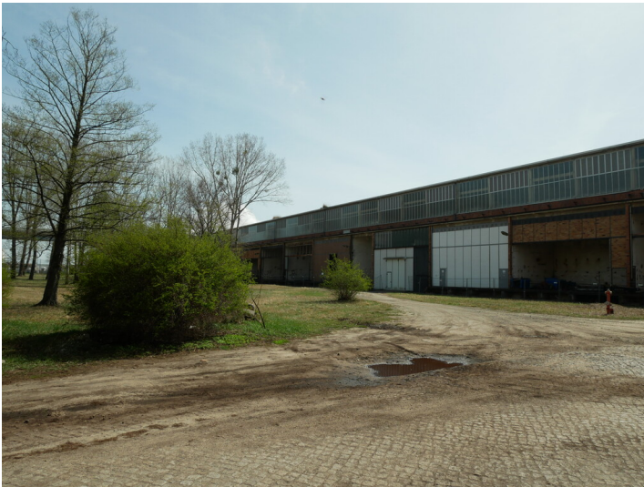
110 kV-Station Fotograf/Urheber: Franz Dietzmann
