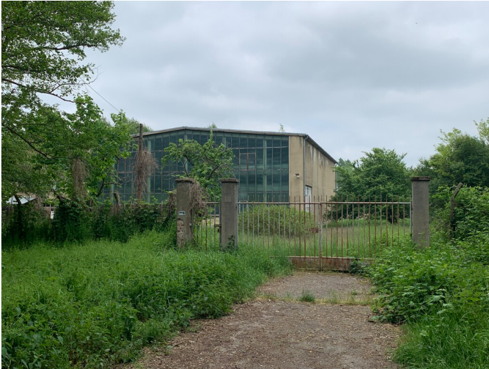
Einlaufbauwerk Burg Fotograf/Urheber: Kaja Boelcke
