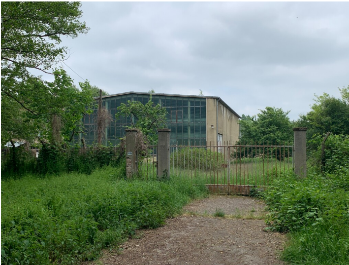
Einlaufbauwerk Burg Fotograf/Urheber: Kaja Boelcke
