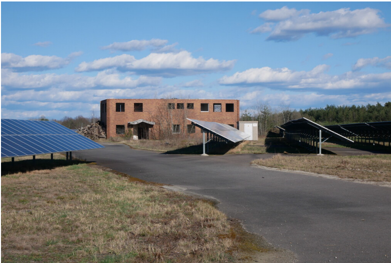
Reparaturplatz Greifenhain Fotograf/Urheber: Franz Dietzmann
