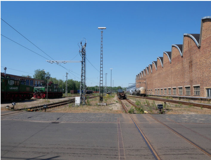
Rangierbereich Hauptwerkstatt Fotograf/Urheber: Kaja Boelcke
