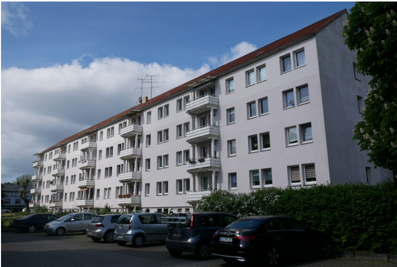
Wohnblöcke der kommunalen Wohnungsverwaltung Fotograf/Urheber: Kaja Boeicke
