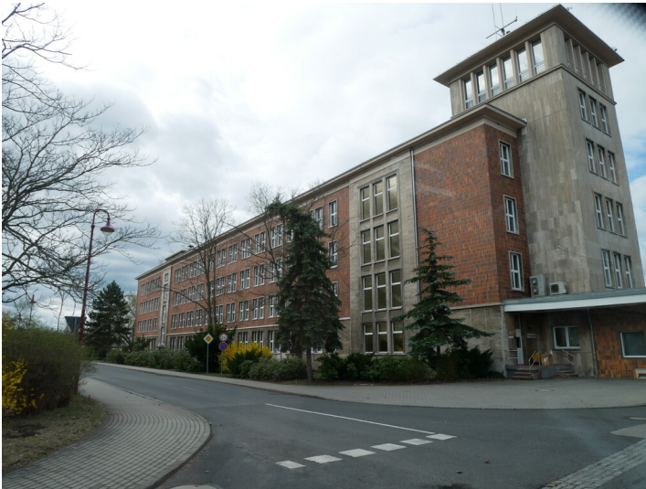
Zentraler Eisenbahn Betrieb Fotograf/Urheber: Franz Dietzmann
