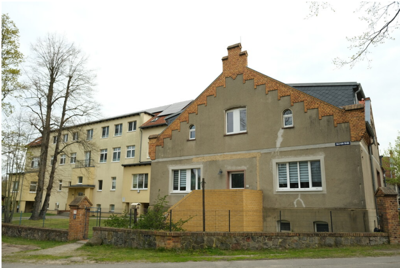
Krankenhaus Altdöbern Fotograf/Urheber: Kaja Boelcke
