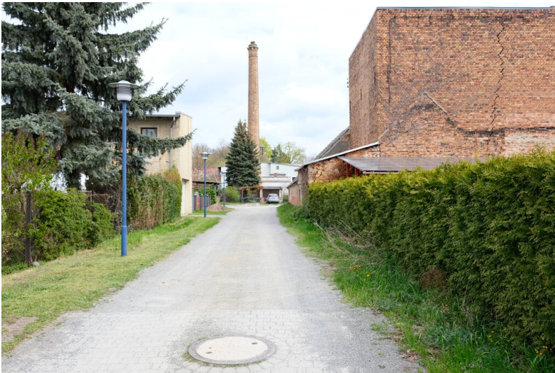
Elektrizitätswerk der Brauerei Altdöbern Fotograf/Urheber: Kaja Boelcke
