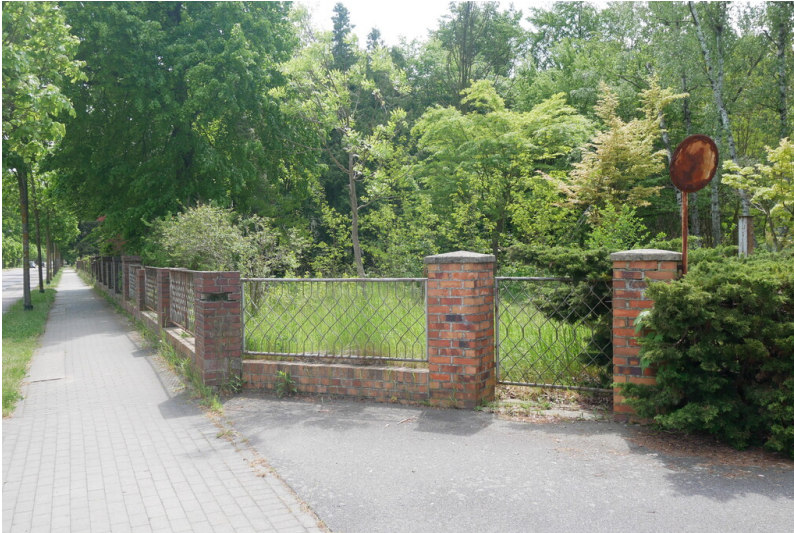
Verwaltung und Umspannwerk Niederlausitzer Überlandcentrale Fotograf/Urheber: Kaja Boelcke
