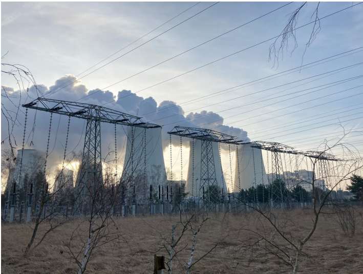
Freileitung Kraftwerk Jänschwalde Fotograf/Urheber: Tanja Trittel
