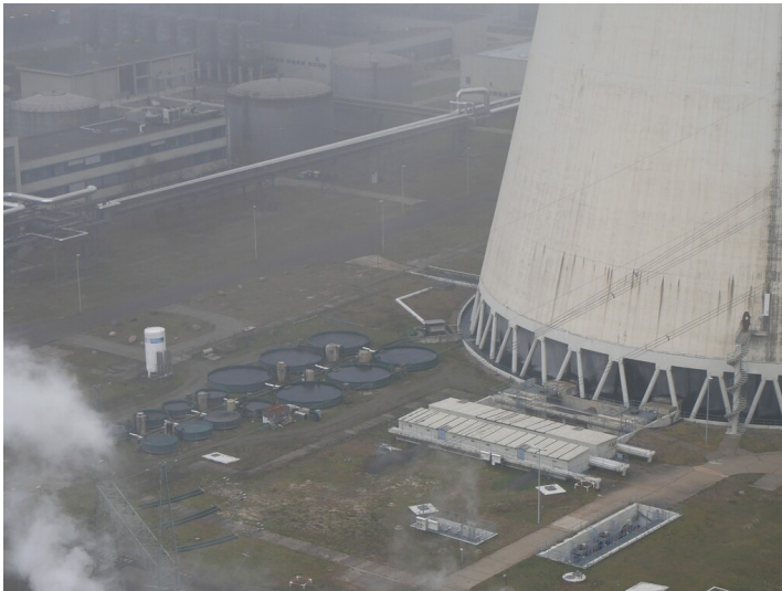
Kraftwerk Jänschwalde Fischzucht (2022) Fotograf/Urheber: Kaja Boelcke
