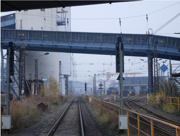
Braunkohleförderbandanlagen Kraftwerk Jänschwalde (2022) Fotograf/Urheber: Alexandra Krug
