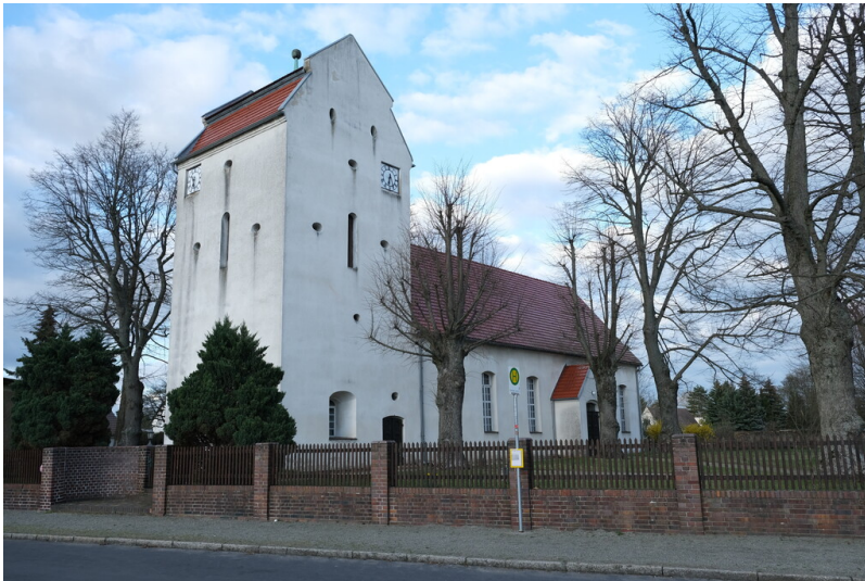
Dorfkirche Freienhufen Fotograf/Urheber: Tanja Trittel
