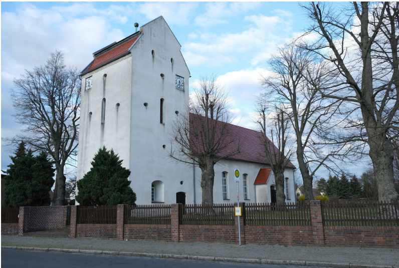
Dorfkirche Freienhufen Fotograf/Urheber: Tanja Trittel
