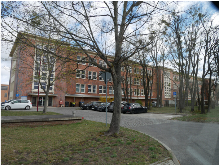
Ausbildungsgebäude und Kaue Fotograf/Urheber: Franz Dietzmann
