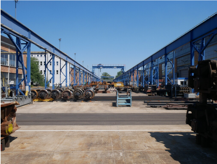
Außenkrananlage Fotograf/Urheber: Dr. Barbara Kündiger
