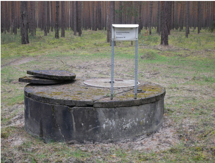
Grundwasserbrunnen BASF Fotograf/Urheber: Franz Dietzmann
