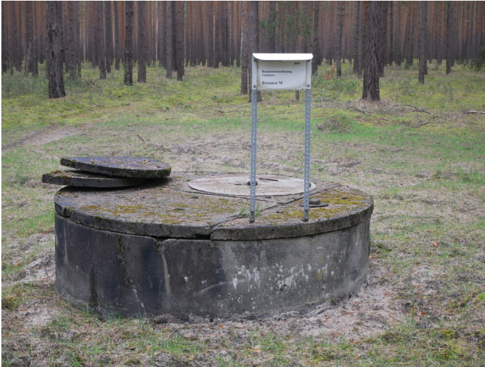
Grundwasserbrunnen BASF Fotograf/Urheber: Franz Dietzmann
