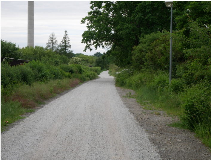
Eisenbahnstrecke ZFE Anschluss Senftenberg Fotograf/Urheber: Tanja Trittel
