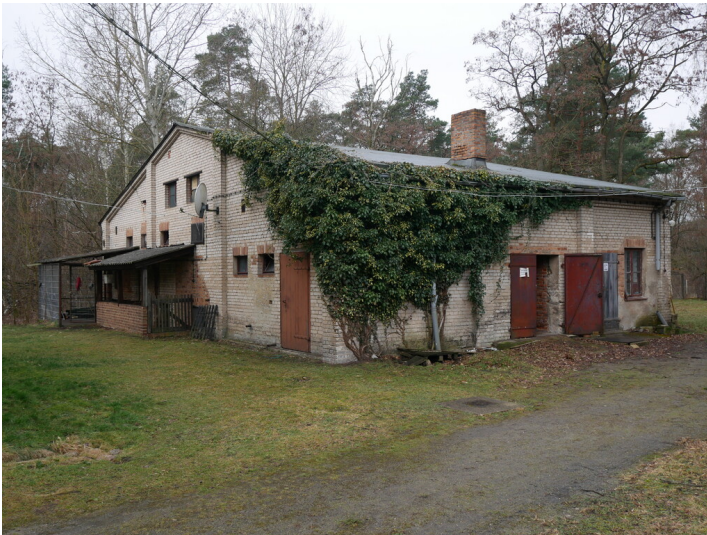
Gebäude Grube Alwine Fotograf/Urheber: Kaja Boelcke
