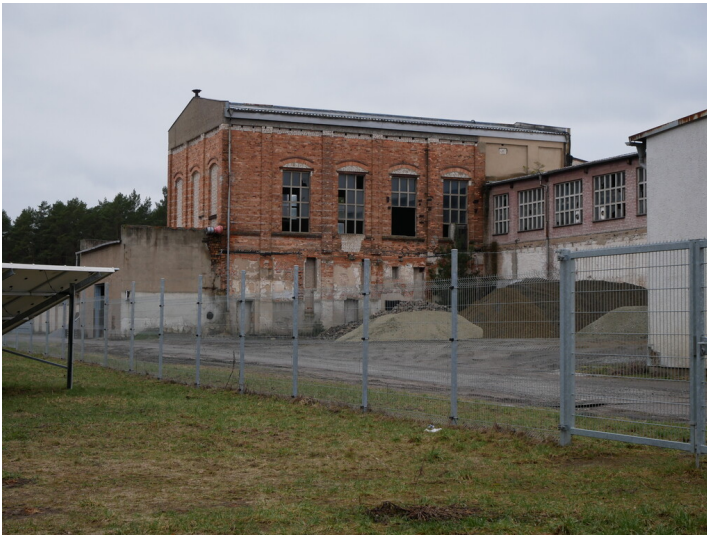
Brikettfabrik Wendisch-Drehna Fotograf/Urheber: Kirsten Krepelin
