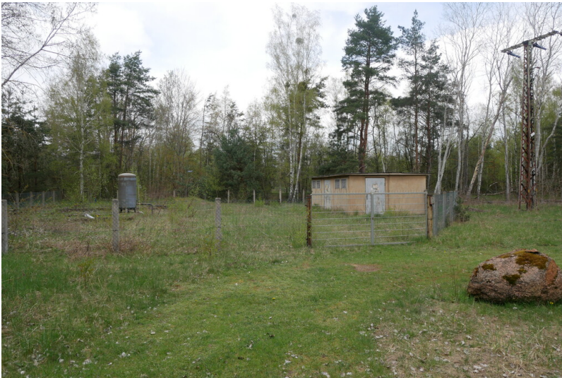
Grubenwasserreinigungsanlage Tagebau Greifenhain Fotograf/Urheber: Franz Dietzmann
