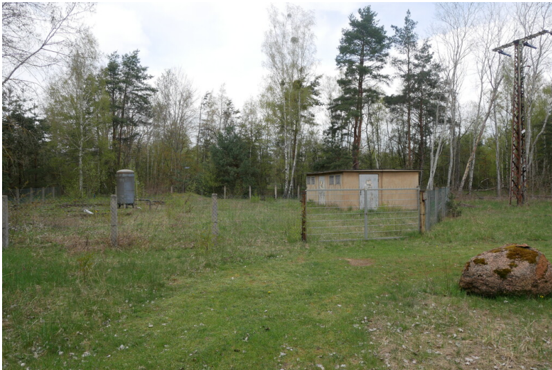
Grubenwasserreinigungsanlage Tagebau Greifenhain Fotograf/Urheber: Franz Dietzmann
