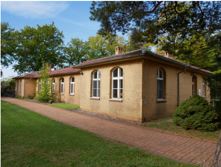
Isoliergebäude Fotograf/Urheber: Franz Dietzmann
