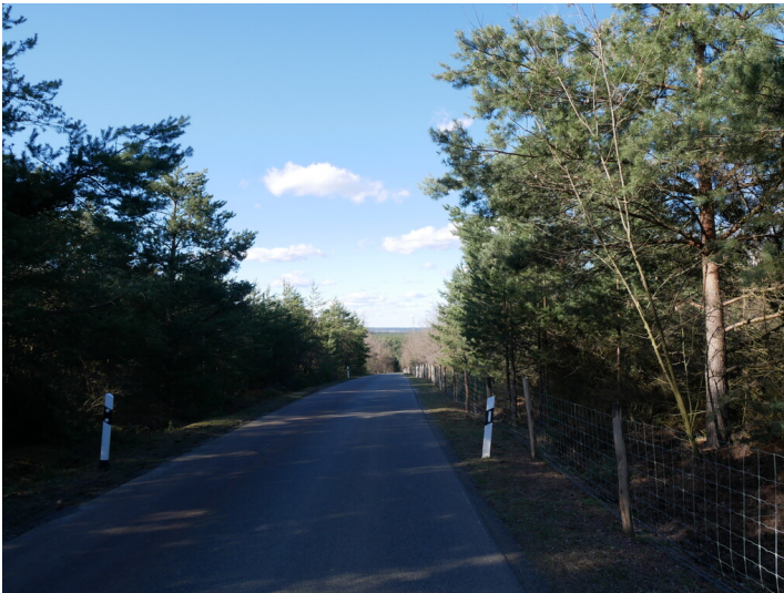
Außenkippe Göritz Fotograf/Urheber: Kirsten Krepelin
