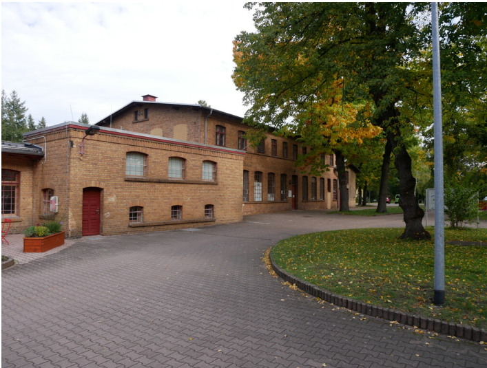
Wirtschaftsgebäude Fotograf/Urheber: Franz Dietzmann
