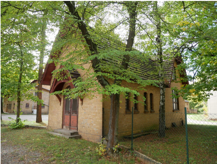
ehem. Leichenhalle und Kapelle des Bergmannkrankenhauses Klettwitz Fotograf/Urheber: Franz Dietzmann
