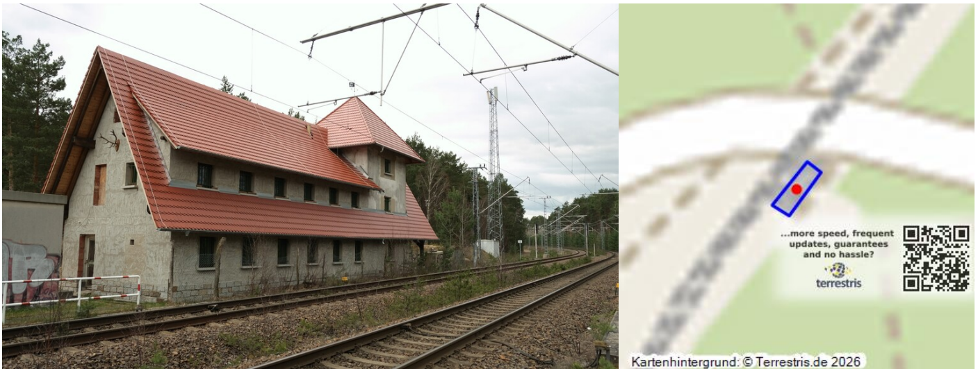
Stellwerk Fotograf/Urheber: Tanja Trittel
