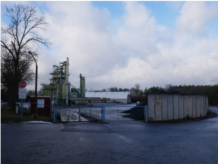
Asphaltmischwerk Vetschau Fotograf/Urheber: Kaja Boelcke
