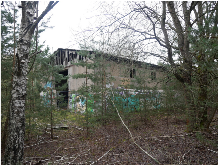
Alte Lagerhalle Fotograf/Urheber: Franz Dietzmann
