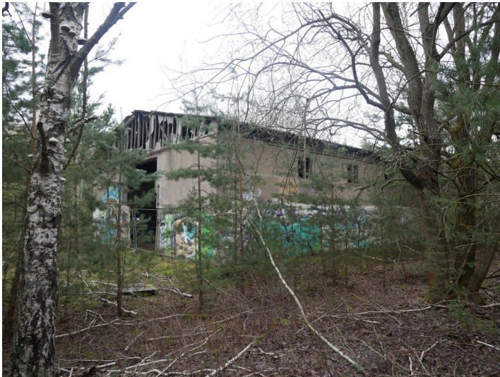
Alte Lagerhalle Fotograf/Urheber: Franz Dietzmann
