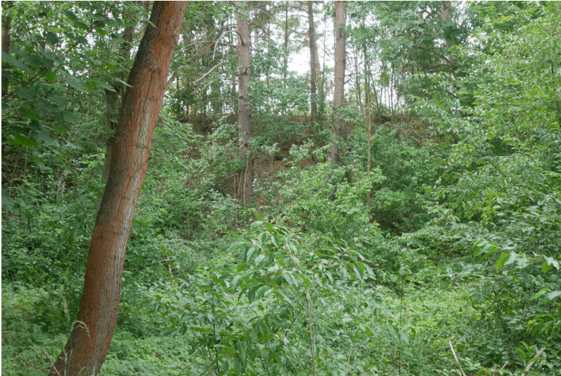
Bahndamm Fotograf/Urheber: Tanja Trittel
