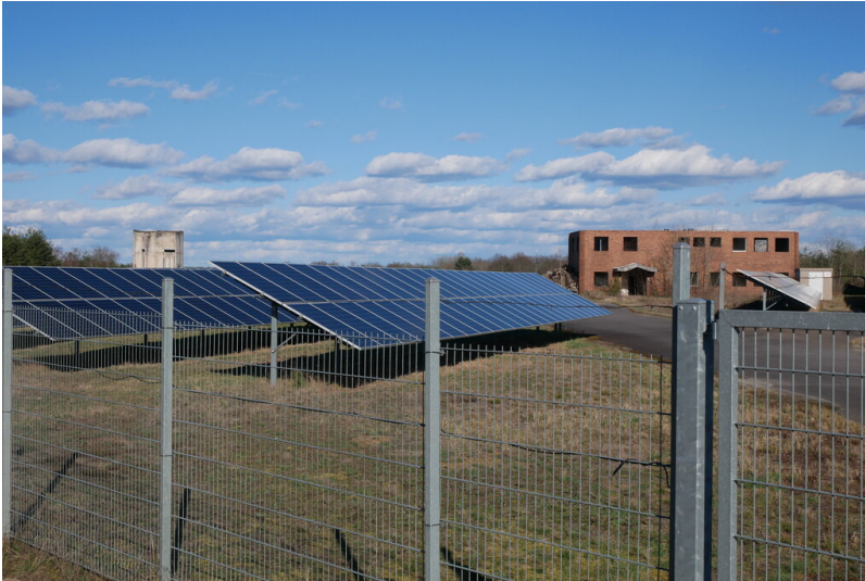
Solarpark Pritzen Fotograf/Urheber: Franz Dietzmann
