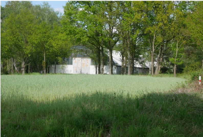
Tagesanlagen Pritzen Fotograf/Urheber: Franz Dietzmann
