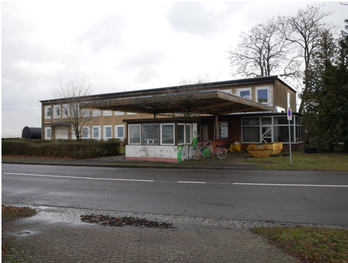
Pförtnerhaus Kraftwerk Vetschau Fotograf/Urheber: Kaja Boelcke
