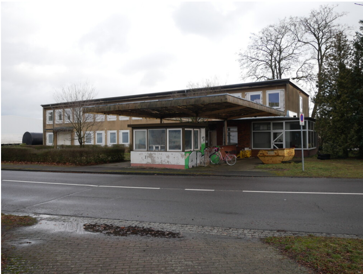
Pförtnerhaus Kraftwerk Vetschau Fotograf/Urheber: Kaja Boelcke
