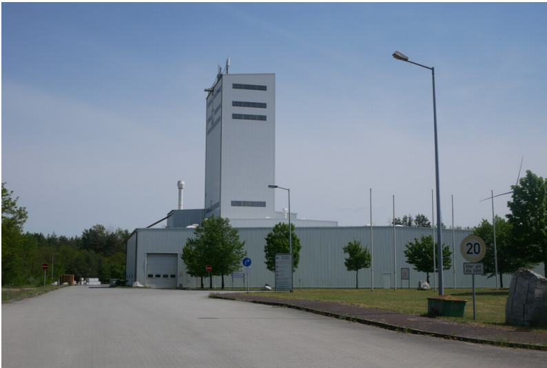
Gipswerk Vetschau Fotograf/Urheber: Kaja Boelcke
