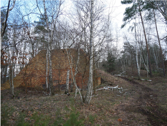
Kohlenschütte Fotograf/Urheber: Kirsten Krepelin
