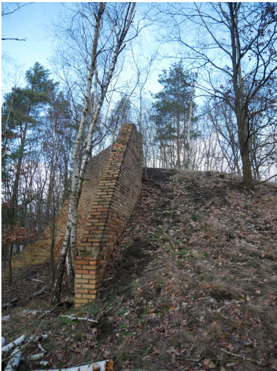
Rampe zur Kohlenschütte Fotograf/Urheber: Kirsten Krepelin
