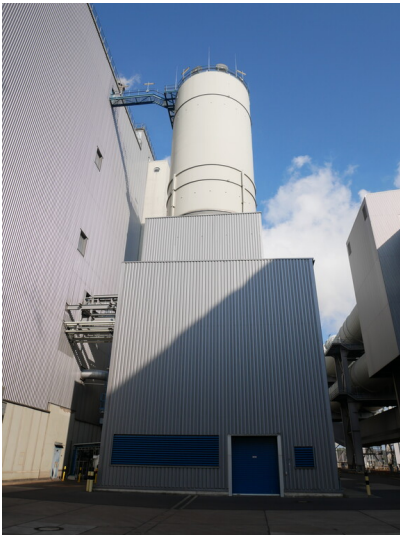
Kraftwerk Jänschwalde Trockenbraunkohle-Anlage (TBK-Anlage)(2023) Fotograf/Urheber: Tanja Trittel
