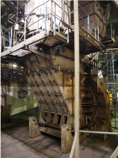
Kohlemühlen Kraftwerk Jämschwalde (2022) Fotograf/Urheber: Kaja Boelcke
