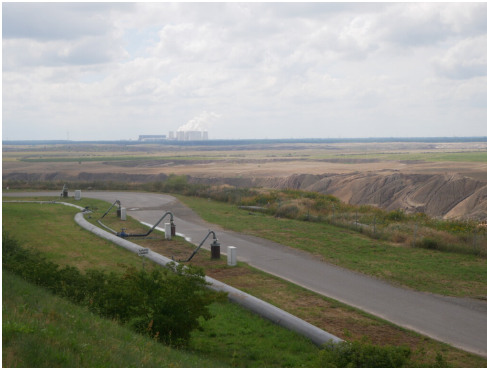
Filterbrunnengalerie Tagebau Jänschwalde Fotograf/Urheber: Franz Dietzmann
