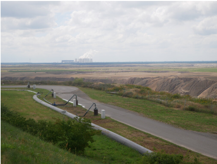
Filterbrunnengalerie Tagebau Jänschwalde Fotograf/Urheber: Franz Dietzmann
