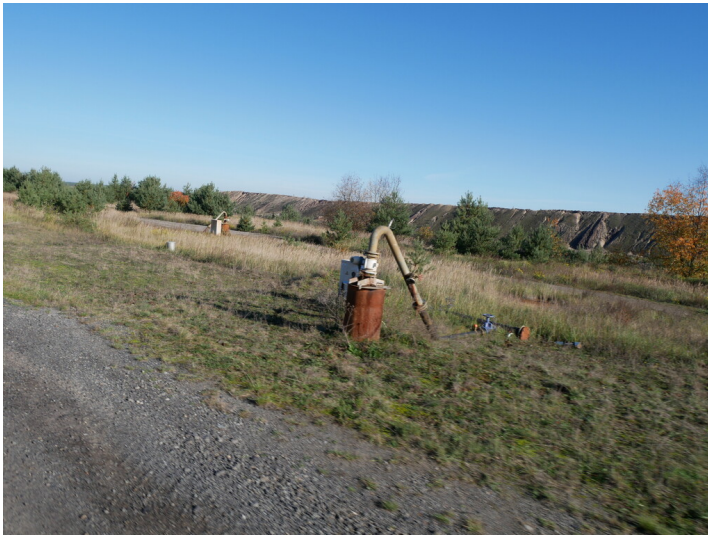
Vorfeldentwässerung Tagebau Jänschwalde Fotograf/Urheber: Stefan Krug
